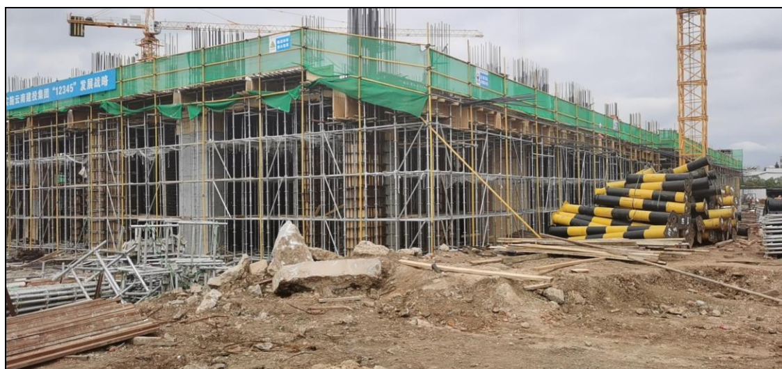
图 1-3 项目现场照片
